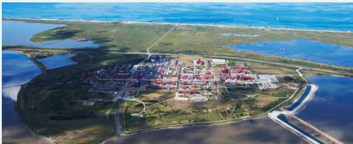
Luftfoto over Rønland fra 2019. Foto: Region Midtjylland
