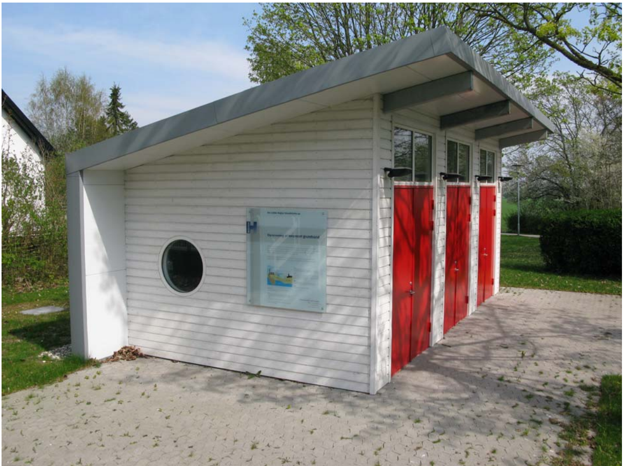
Regionens standardbygning for afværgeanlæg, Reerslev
