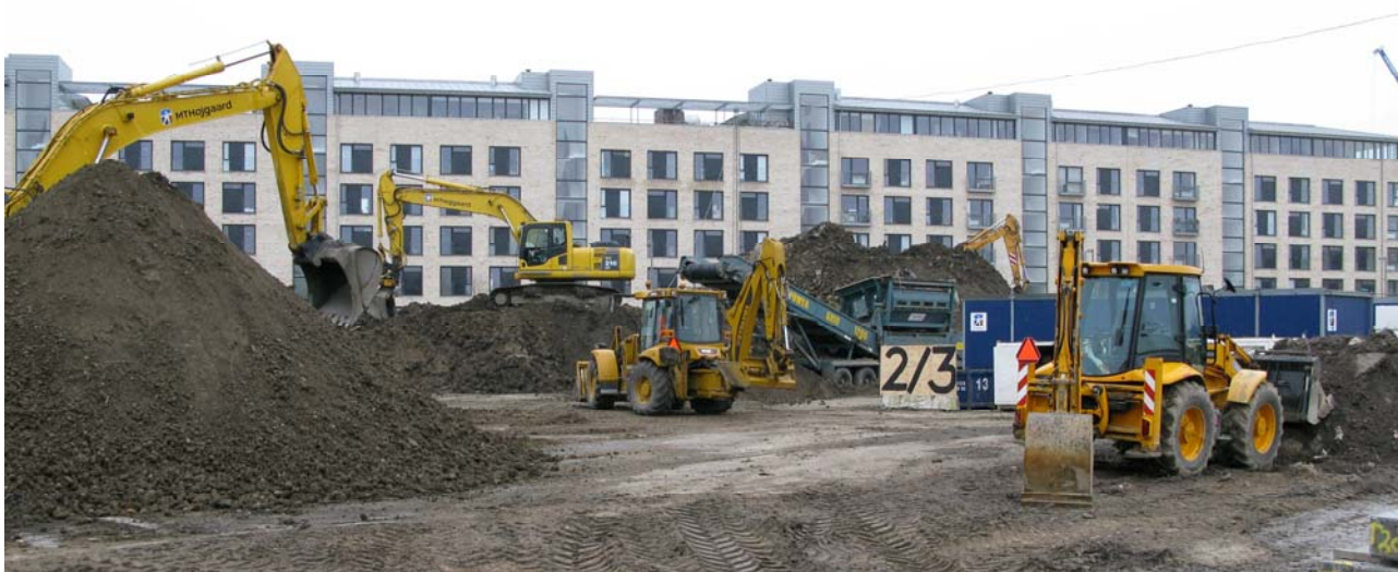
Frivillig oprydning, før byggeri, på tidligere gasværksgrund, Frederiksberg
