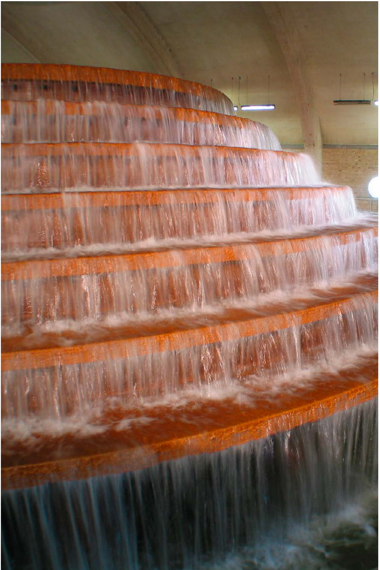
Simpel vandbehandling på et vandværk består i iltning og filtrering, der fjerner naturlige stoffer som jern og mangan fra vandet.
