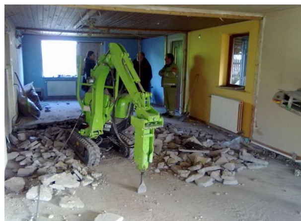
Gulvet blev brækket op og der blev fjernet en halv meter jord. Herefter blev der lagt et ventilerende drænlag og gulvet blev retableret
