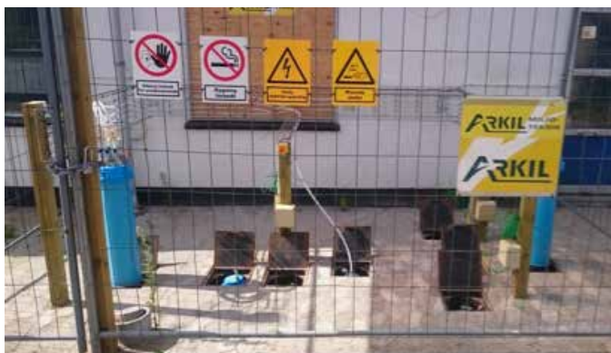
Figur 7. Oprensning ved elektrokinetisk assisteret kemisk oxidation.
