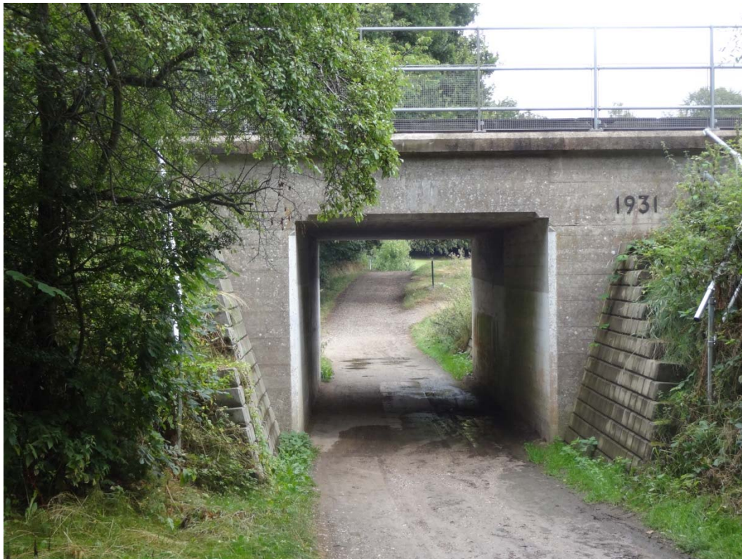
Figur 11. Eksisterende bro under S-banen.
