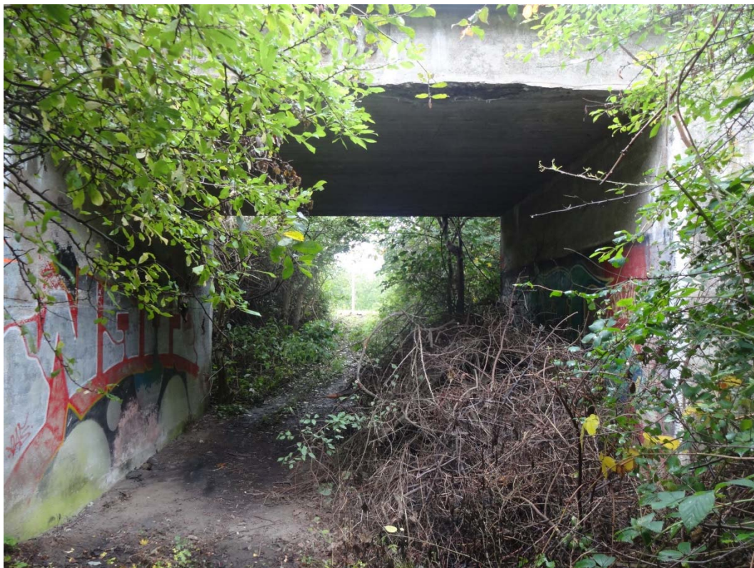
Figur 12. Eksisterende bro under Frederiksværkbanen
