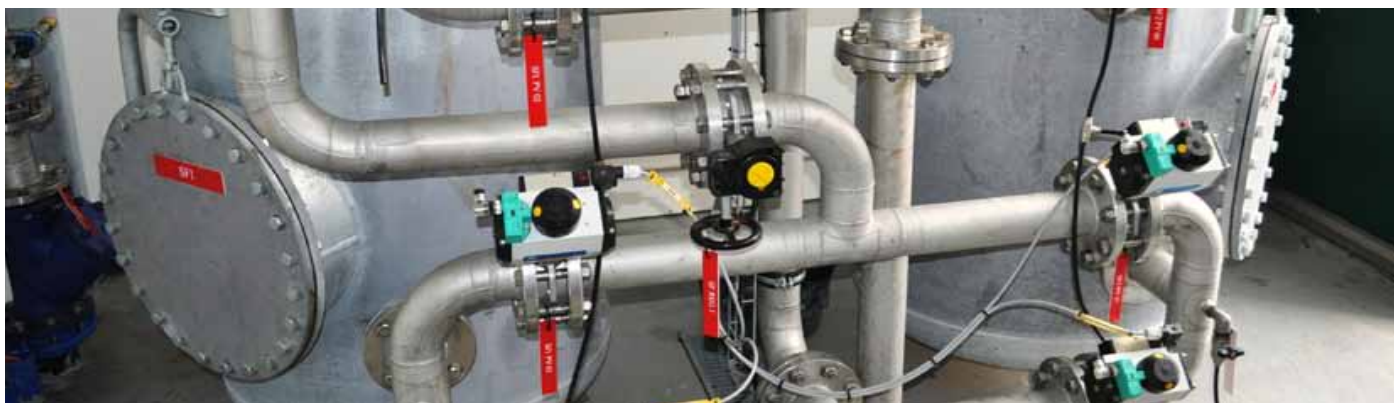
Teknisk oprensningsanlæg der renser forurenet grundvand
