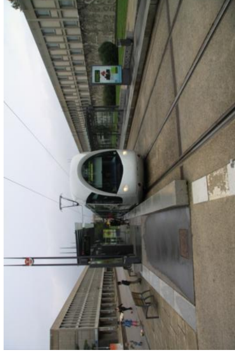
Figur 2-7: Eksempel på station med sideperroner beliggende overfor hinanden
